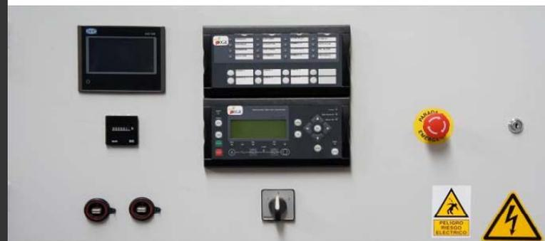
Acceso a diagnóstico PC detallado mediante un simple cable USB, los módulos incorporan dos puertos, uno de ellos para la obtención de datos del motor y otro para la gestión integral del CHP.
